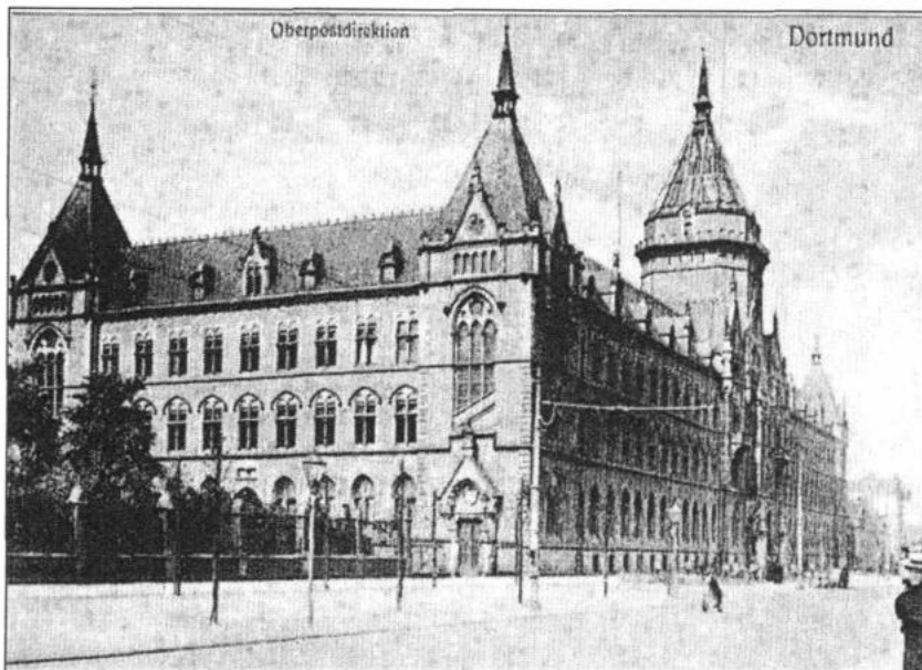
Erste OPD mit Telegraphenstation (rechter Turm) am Hiltropwall in Dortmund
