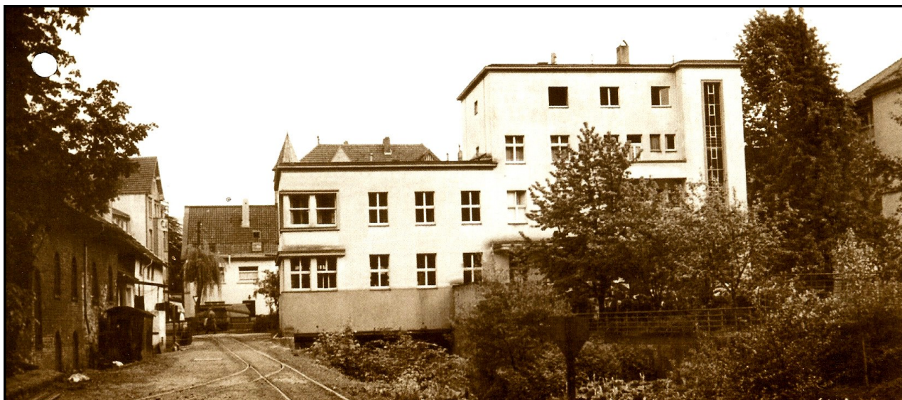
Rückansicht des Postamtes in Plettenberg, Maipplatz 3. Der über dem Oesterbach errichtete Teil des Gebäudes wurde nur zweistöckig bebaut. Links anschließend das Haus Lohmann. Der Abbruch dieses Gebäudes erfolgte am 31. 8. 1960, weil es aus damaliger Sicht den Verkehr zu sehr behinderte. Am linken Bildrand die Fa. Brandhoff sowie die Dunkelsche Mühle (eines der ältesten Bauwerke in Plettenberg). Auch diese Gebäude wurden abgerissen.
